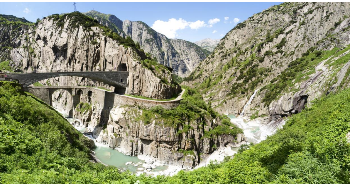
Pont traversant la Reuss permettant d'atteindre le col du Saint-Gotthard
